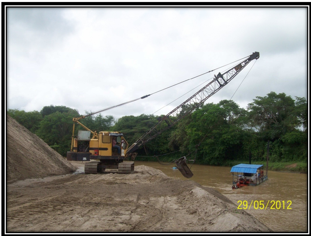
Foto 6. Retiro de Sedimentos en canales
